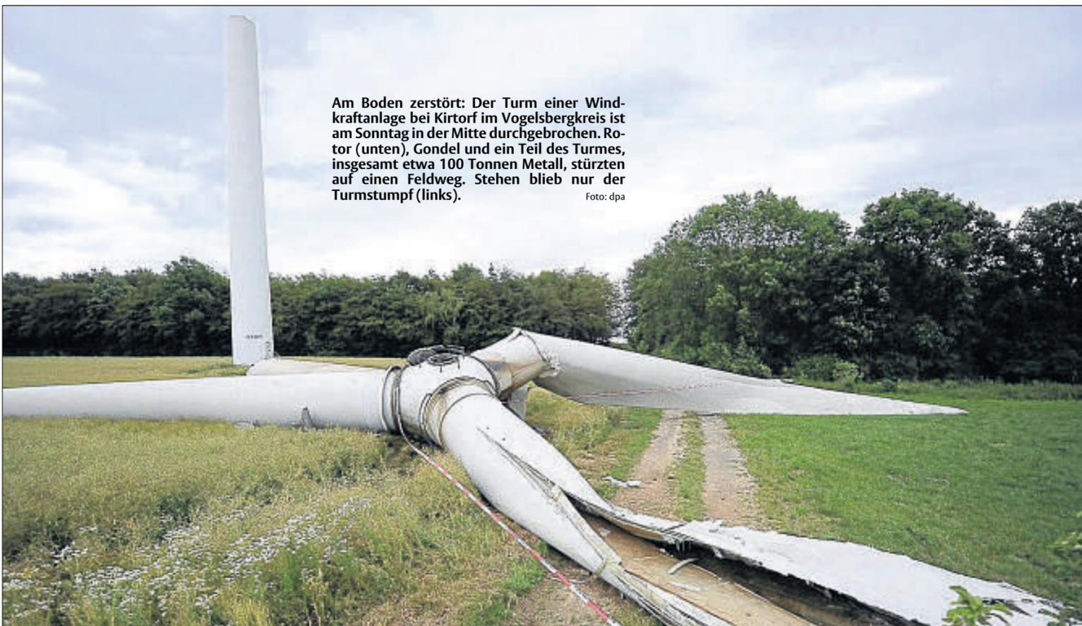
Am Boden zerstört: Der Turm einer Windkraftanlage bei Kirtorf im Vogelsbergkreis ist am Sonntag in der Mitte durchgebrochen. Rotor (unten), Gondel und ein Teil des Turmes, insgesamt etwa 100 Tonnen Metall, stürzten auf einen Feldweg. Stehen blieb nur der Turmstumpf (links). Foto: dpa
