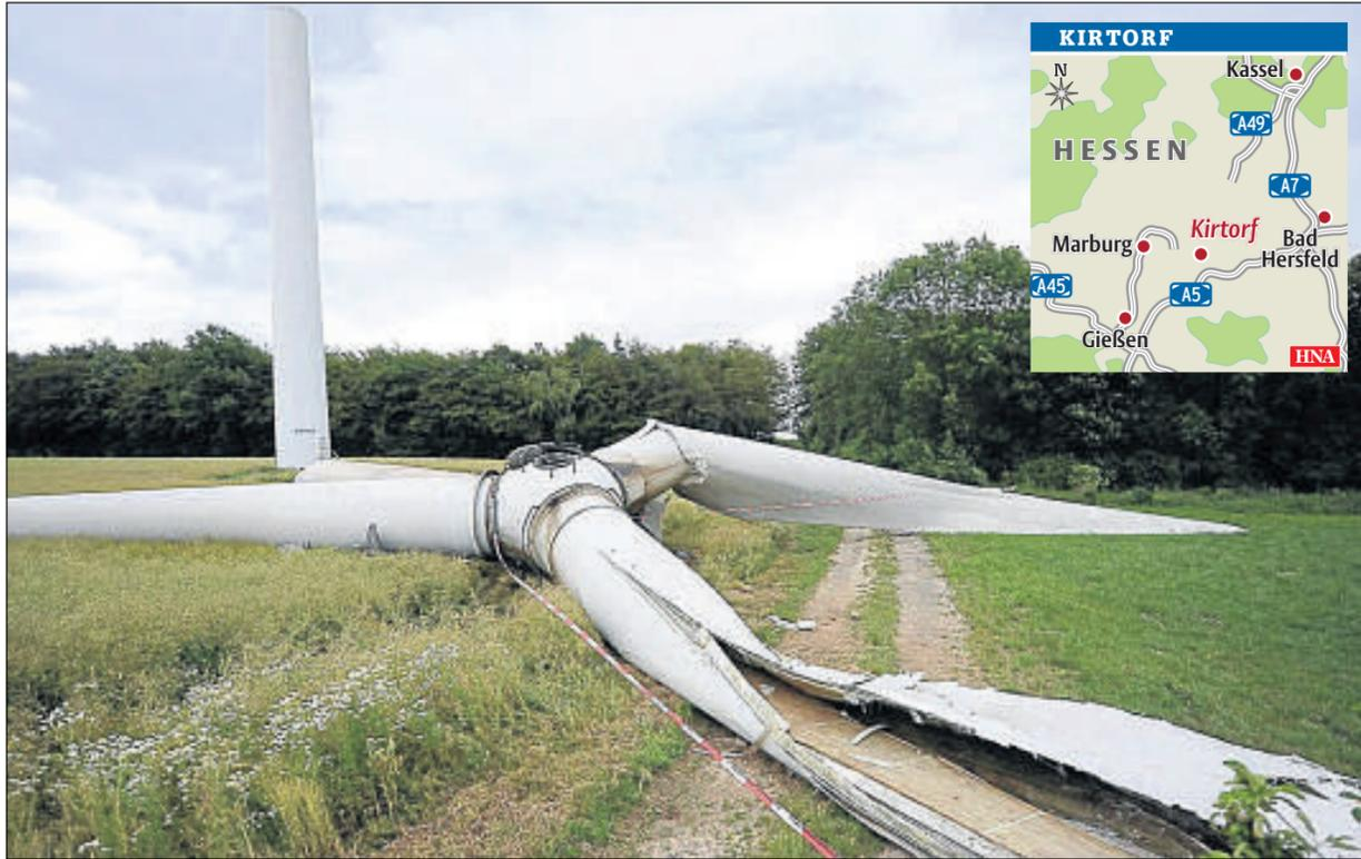
Am Boden zerstört: Der Turm einer Windkraftanlage bei Kirtorf im Vogelsbergkreis ist am Sonntag in der Mitte durchgebrochen. Rotor (im Vordergrund), Gondel und ein Teil des Turmes, insgesamt etwa 100 Tonnen Metall, stürzten auf einen Feldweg. Stehen blieb nur der Turmstumpf (im Hintergrund).
